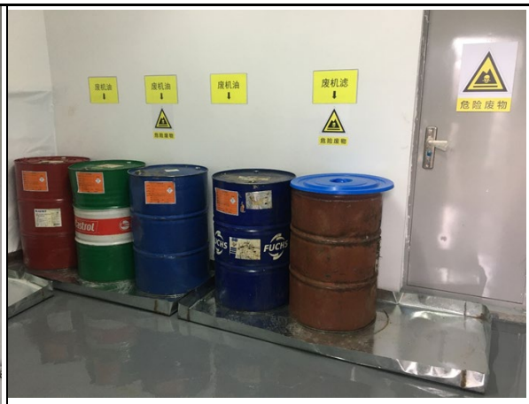
1#危废暂存间内部照片(防渗涂层、托盘、分类存放)
