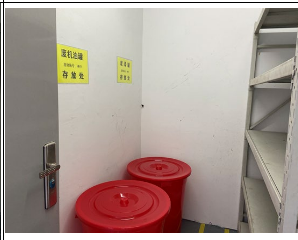
3#危废暂存间内部照片(防渗涂层、分类存放)
