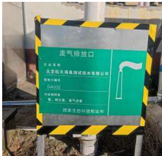
一体化污水处理设施恶臭废气排气筒 DA002
