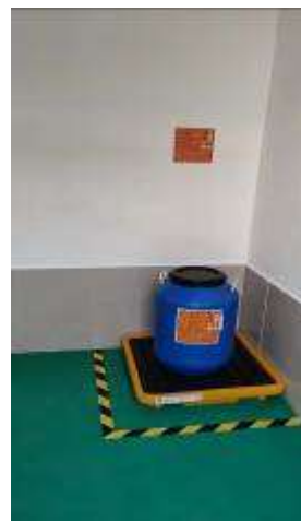
二级碱喷淋装置废吸收液 设置托盘
