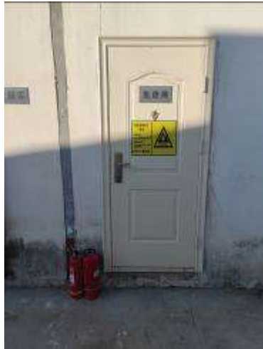
危险废物暂存间
