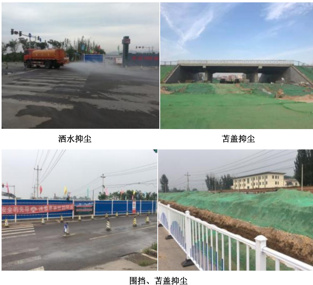
图 6-7 本项目施工期大气环保措施照片
