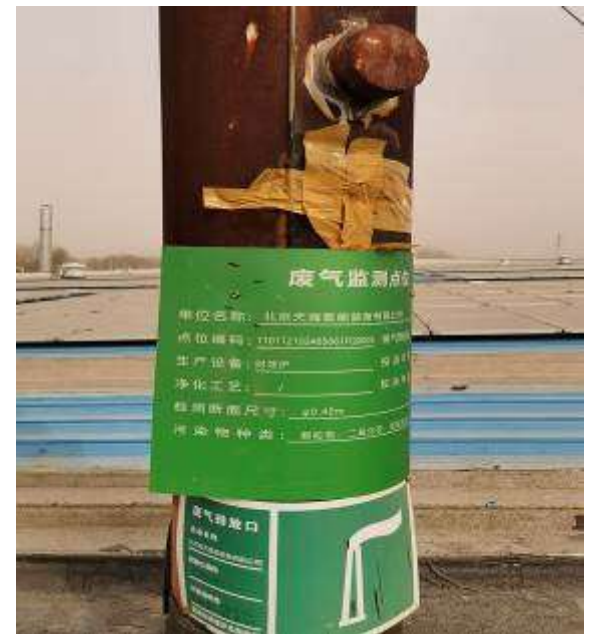
DA005 废气排放口及监测点位标识牌
