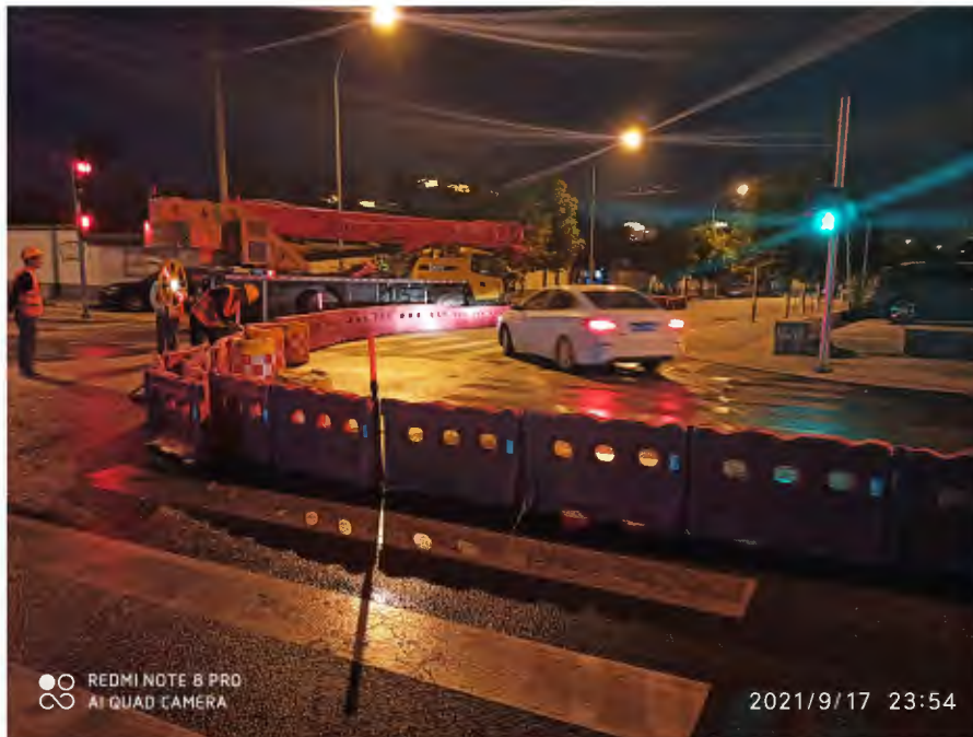
图7 施工期车辆导流照片
