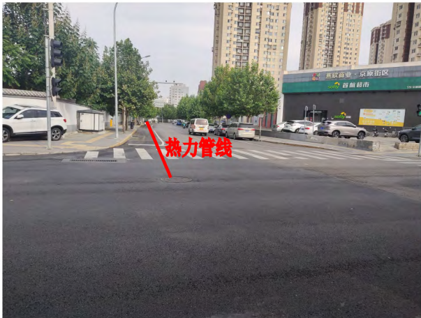
西院支路干线起点现状照片
