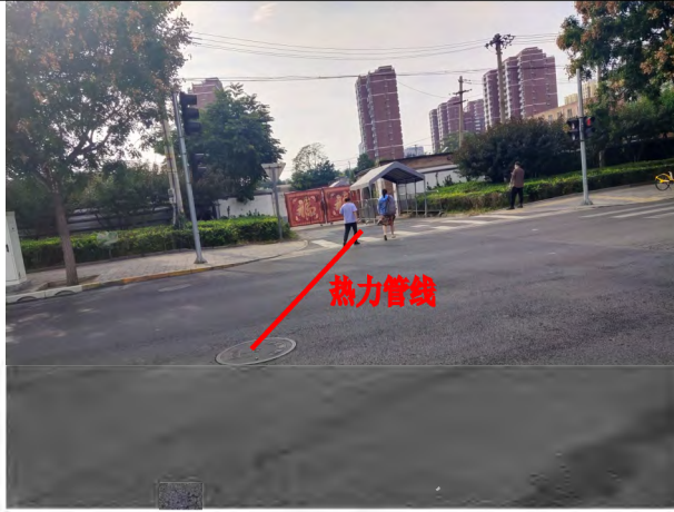
西小园支路管线现状照片
