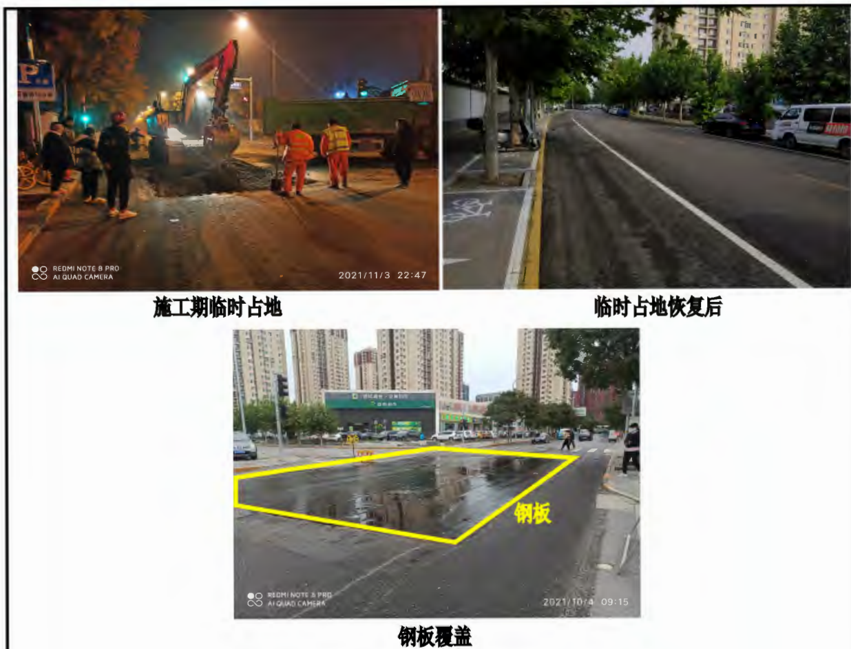
图5 施工期临时占地恢复前后对比照片及钢板覆盖照片
