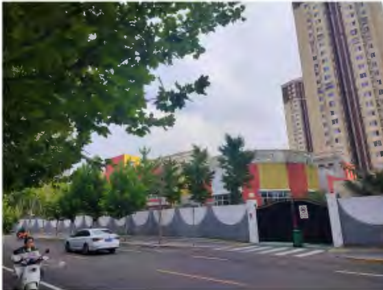
北京市石景山区幼儿园现状照片
