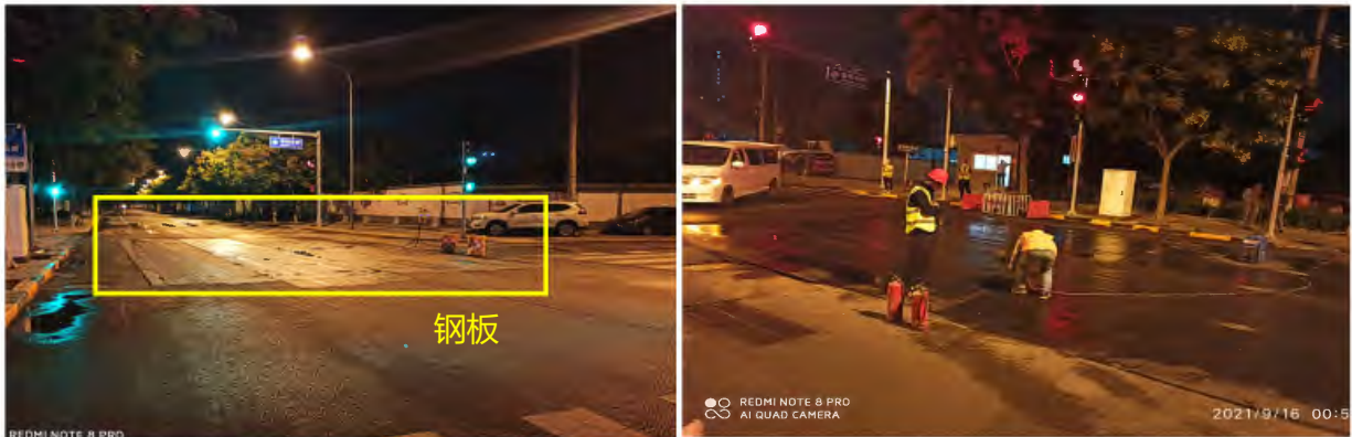
图6 施工期钢板覆盖及洒水照片
