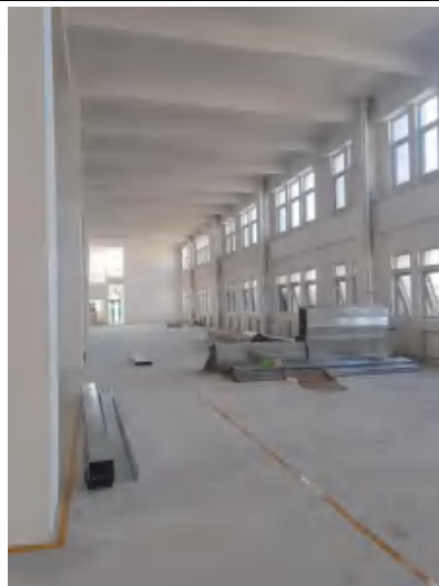
图 2-7 本项目所在建筑内部现状照片
