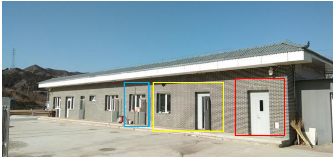
项目东侧（红框：配电室）及项目西侧（蓝框：厨房）
