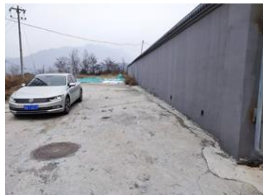
项目北侧（红框：山地）
