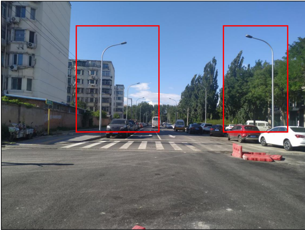
图8 冷泉二号街验收阶段照明工程现状照片
