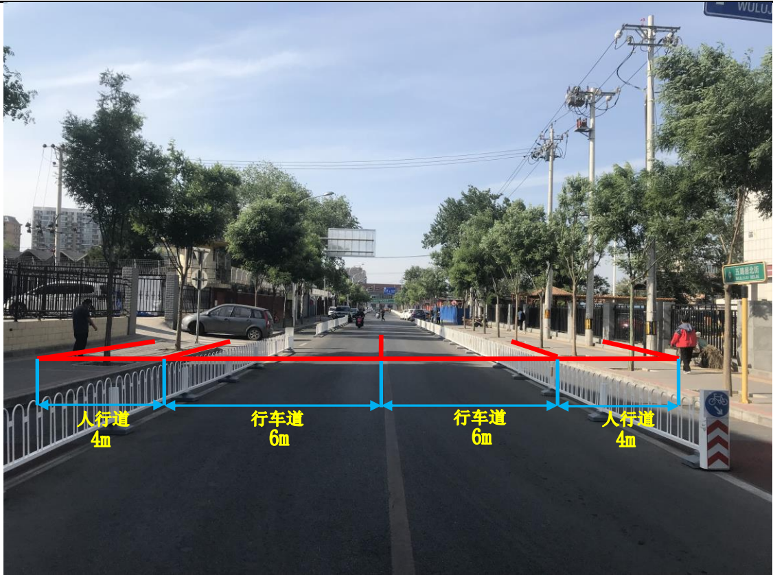
图4 五路居中路（现状五路居北街）道路横断面实景图
