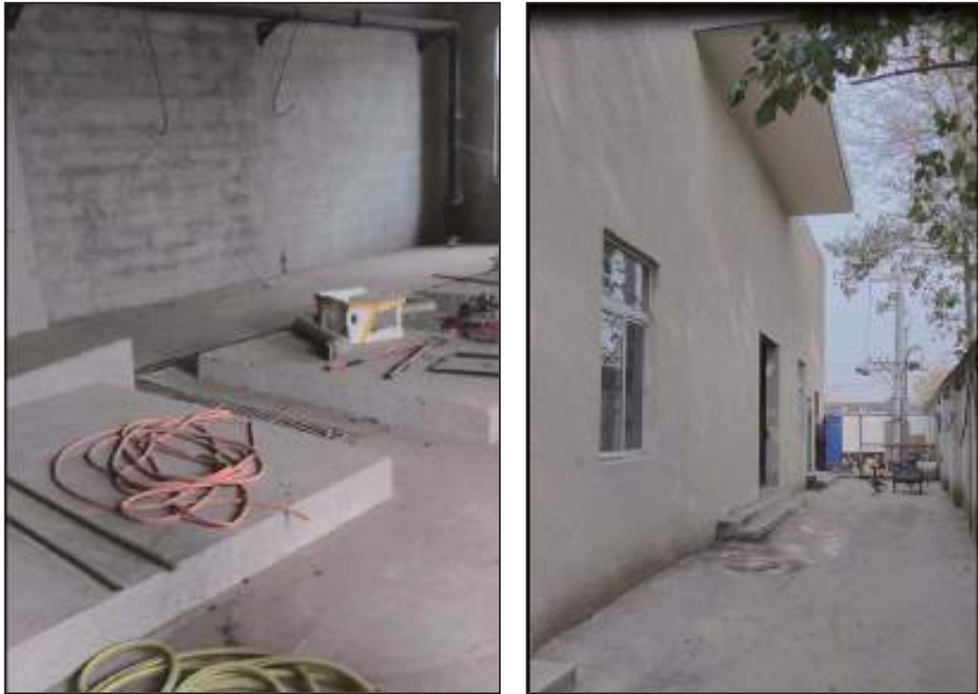
图 4 项目锅炉房现状图
