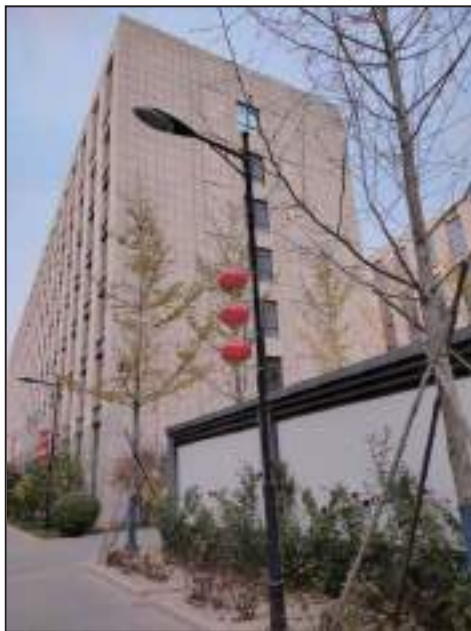
西侧-永安达 2 号楼
