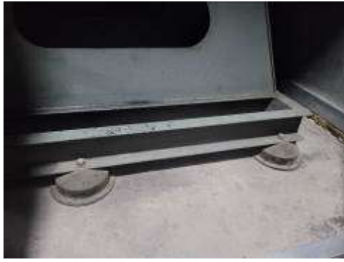
生产设备基础减震
