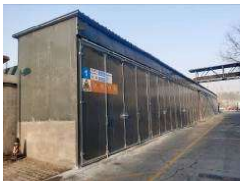
危险废物暂存间
