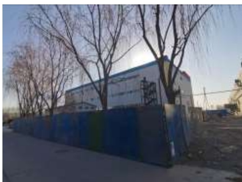
施工区域设置防护屏
