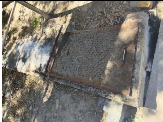
北京英惠尔生物技术有限公司废水排放口
