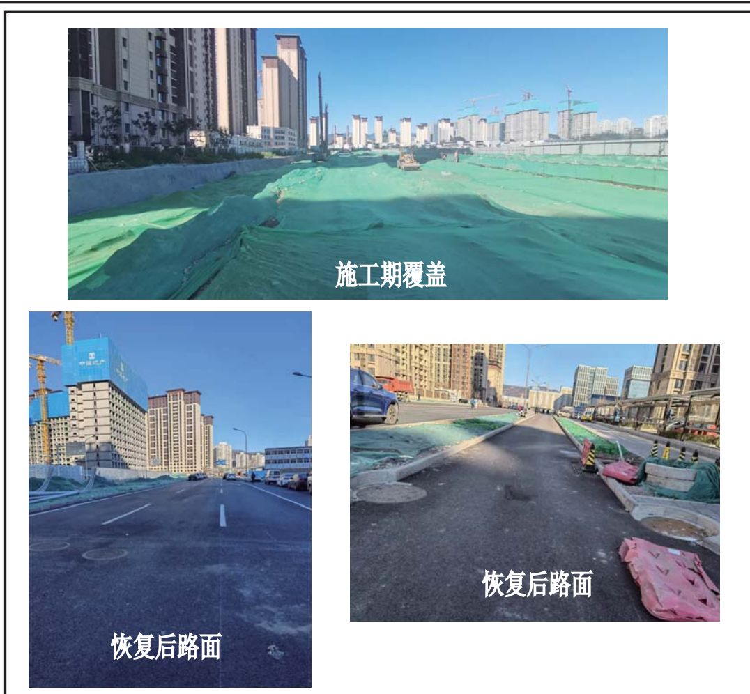
图 4 项目生态环境保护措施及用地恢复现状照片
