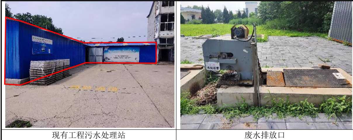
图6 现有工程污水处理站及废水排放口现状照片
