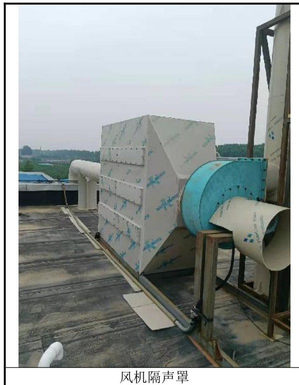
图7 降噪措施现状照片
